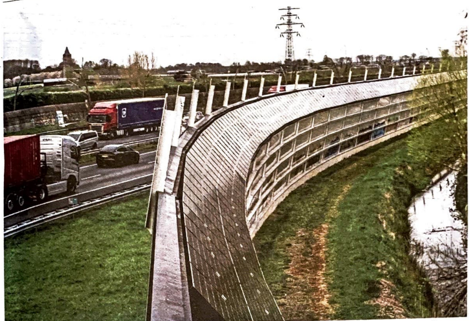
▲ Zonnepanelen op een geluidswal langs de snelweg A15. Utrechtse Heuvelrug wil zonnepanelen van Bunnik tot Ede plaatsen. FOTO RAPHAEL DRENT
