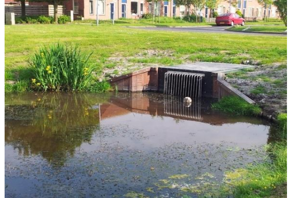
Voorbeeld riool overstort op vijver.
