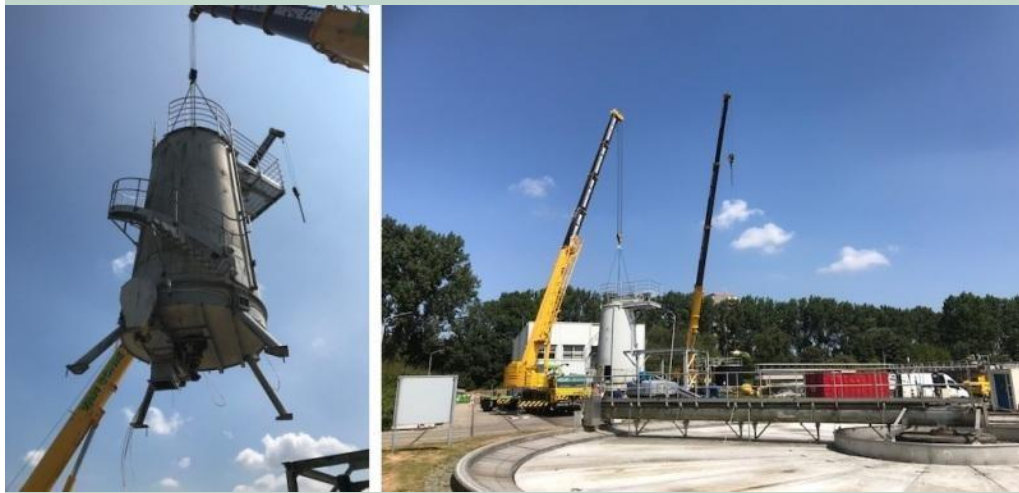
Bouw energiefabriek Zaandam-Oost
