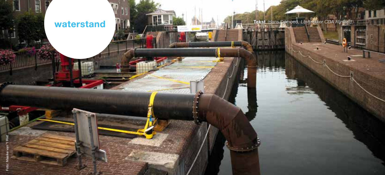
In verband met de droogte werden extra pompen geplaatst in Muiden
