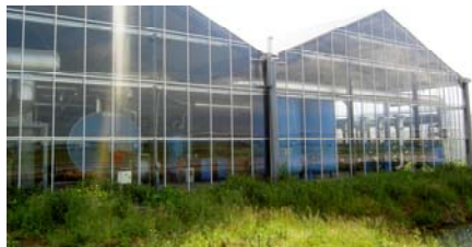
In de Nederlandse tuinbouw wordt innovatie toegepast om duurzame energie te verkrijgen. Hier energie-producerende kassen te Lingewaard.
