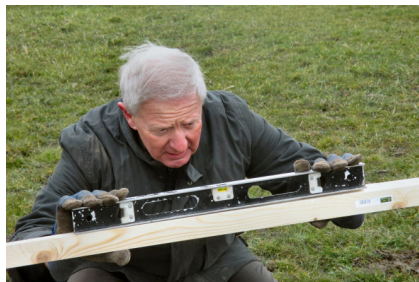
Jan Schuurung stelt het frame waterpas
