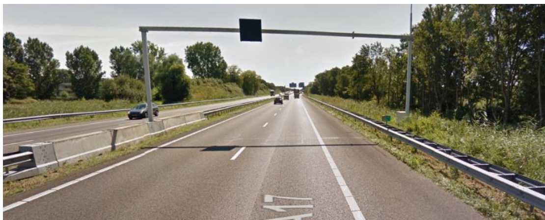
A17 – Hoofdrijbaan rechts t.h.v. afrit 19 (knooppunt de stok).
