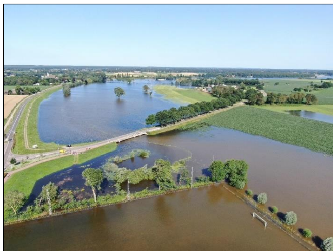
Hoogwater Niersdal ter hoogte van de Oordse brug
