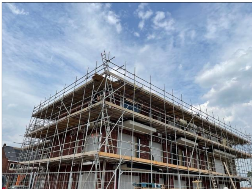
Woon-zorg complex Ottersum in aanbouw
