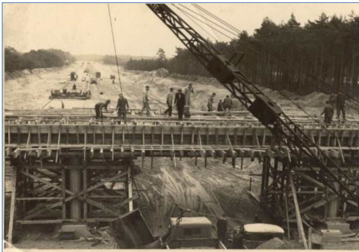
Aanleg viaduct Elspeterweg
